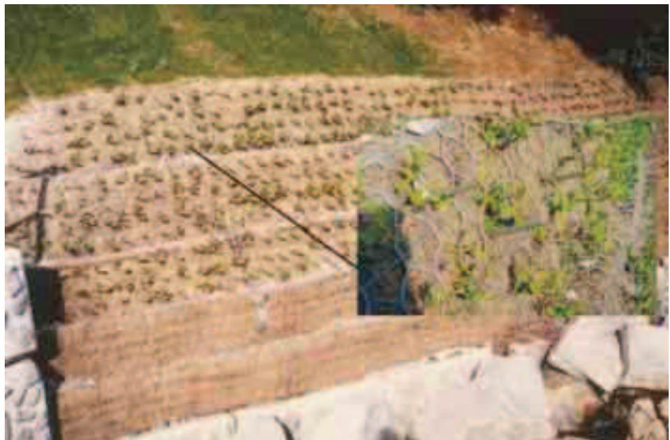
**Figura 6.3.19:** Intervento di ricostituzione di un versante prospiciente il fiume Reno. Al piede della scarpata è stata realizzata una terra rinforzata con paramento riempito in pietrame con il duplice effetto di costituire una base stabile al terrapieno in terra rinforzata verde e di fornire la difesa all'erosione nel caso di piene.
