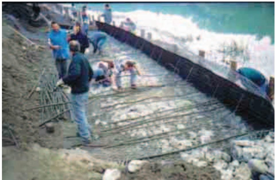
Le opere che si potranno realizzare con i sistemi descritti sopra saranno tutte caratterizzate da estrema flessibilità e quindi particolarmente adatte alle applicazioni di stabilizzazione delle sponde in frana. Le terre rinforzate a seconda dei sistemi utilizzati potranno inoltre essere permeabili all'acqua ed alla vegetazione.
