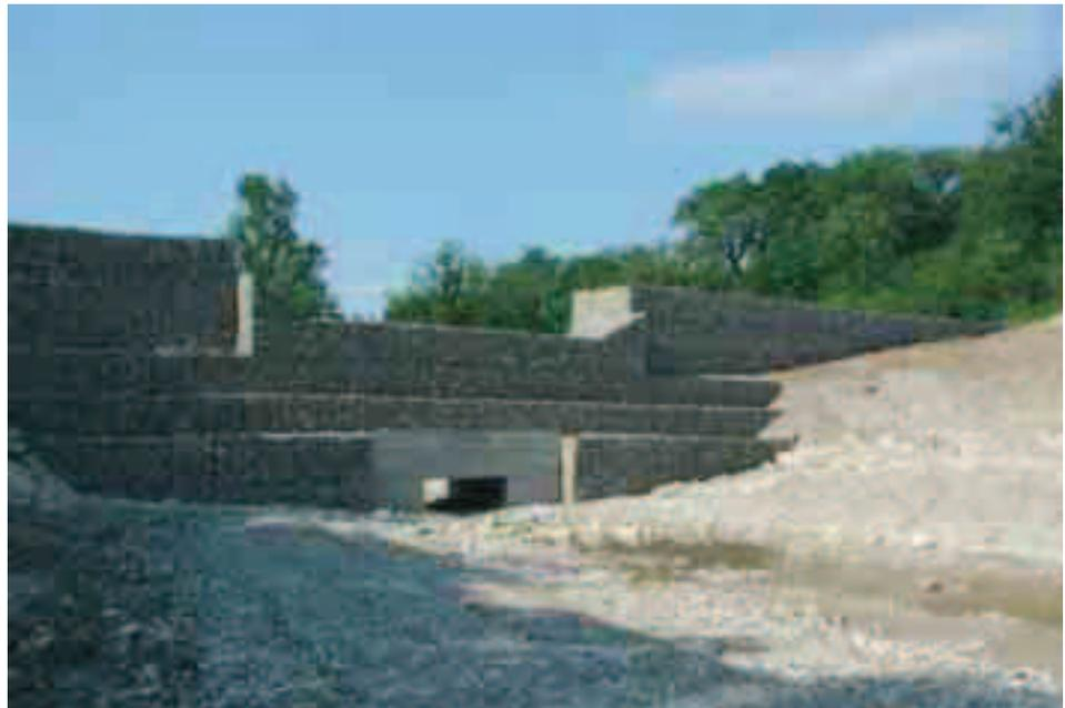
**Figura 6.1.12:** Sistemazione di un torrente con briglie in gabbioni in ambiente calanchivo (Petràlia PA).
