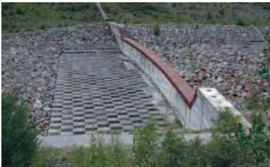
**Figura 6.1.4:** Sistemazione a gradinata in gabbioni e materassi. Lavori complementari sulla autostrada Messina - Palermo.
