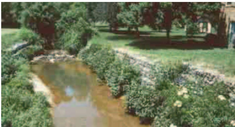
**Figura 6.3.26:** Gabbionata rinverdata. I singoli elementi scatolari hanno lunghezza diversa in modo da gradonare il paramento del muro. Durante la costruzione, nella porzione al di sopra del livello medio dell'acqua, sono state messe a dimora delle talee di salice che consolidano la struttura e consentono una buona rinaturalizzazione delle sponde in tempi relativamente brevi.
